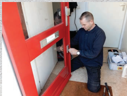
De slotenmaker plaatst een kerntrekbestendige cilinder.
